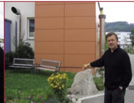
Die Zu- und Abluftrohre sorgen beim Passivhaus für den nötigen Luftaustausch.
